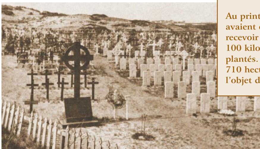
Travaux de construction en cours au Cimetière Militaire de Coxyde en Belgique
